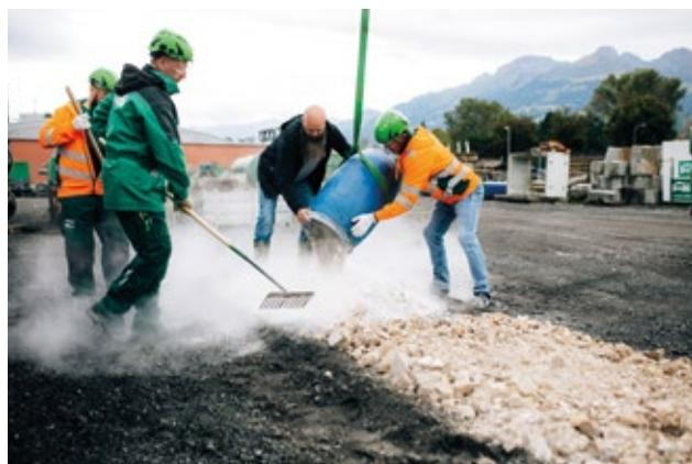
Der gebrannte Kalk wird ausgebreitet und im Anschluss gelöscht.
